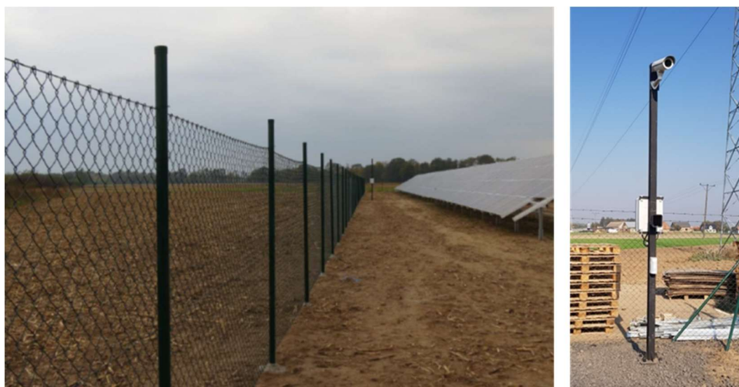
Ryc. 16. Przykładowe ogrodzenie i kamera monitoringu.
