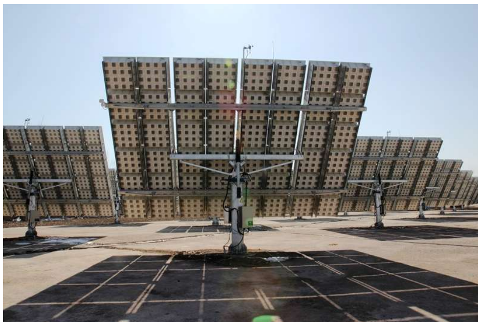
Ryc. 24. Przykładowe panele z systemem trakcyjnym typu „dual axis”. Źródło danych: https://www.wikiwand.com/en/Solar_tracker
