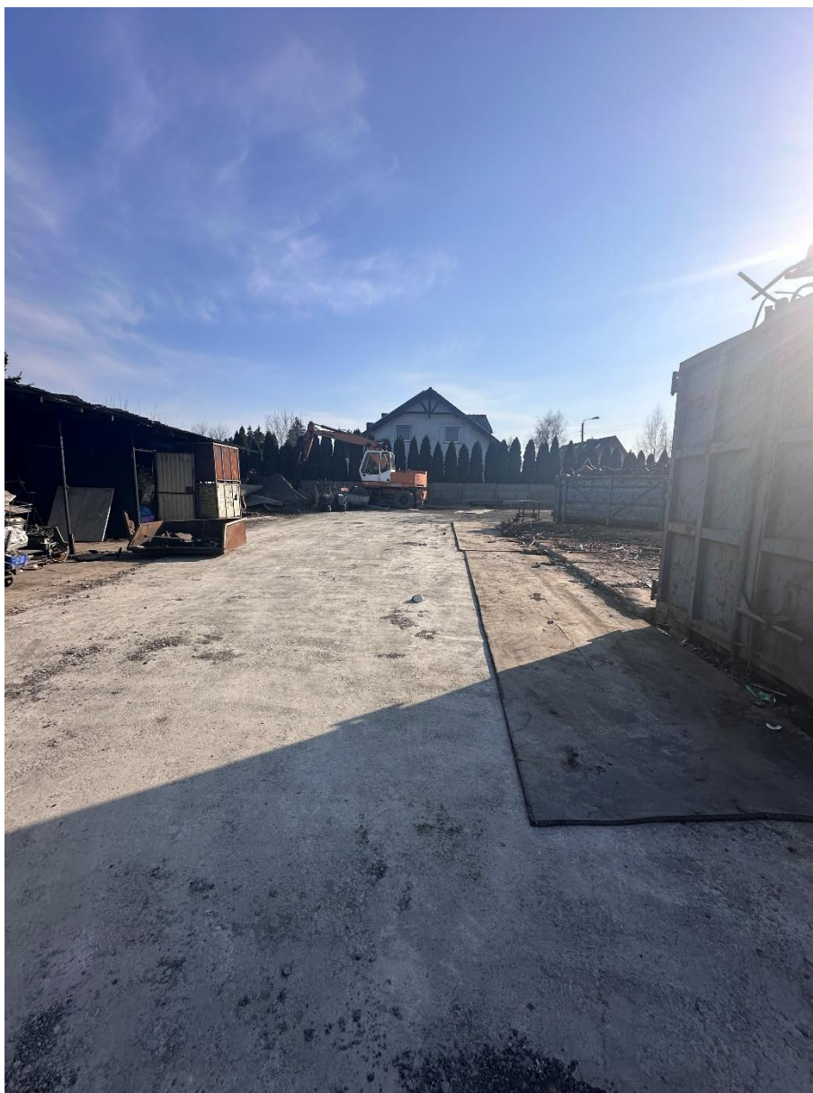
ZDJĘCIE 2: WIDOK OD STRONY PÓŁNOCNEJ, PO LEWEJ STRONIE WIATA MAGAZYNOWA
