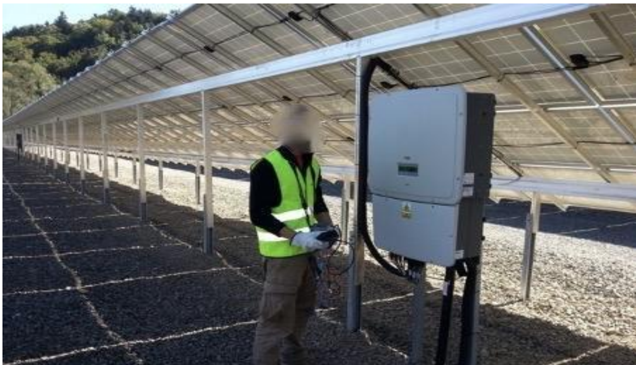
Fot. 5. Instalacja zamontowana pod konstrukcją paneli na pracującej farmie fotowoltaicznej (źródło: www.solgen.pl ).
