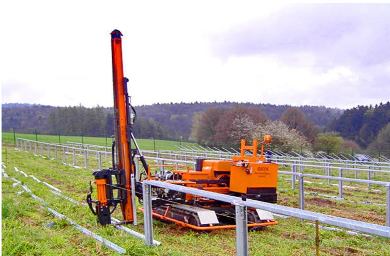
Fot. 1. Maszyna wciskająca konstrukcje stalowe w grunt (źródło: www.projekt-solarteknik.pl ).
