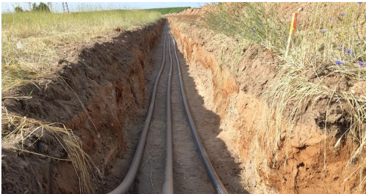
Fot. 4. Rów kablowy z ułożonymi przewodami (źródło: www.eletromontazwschod.pl ).
