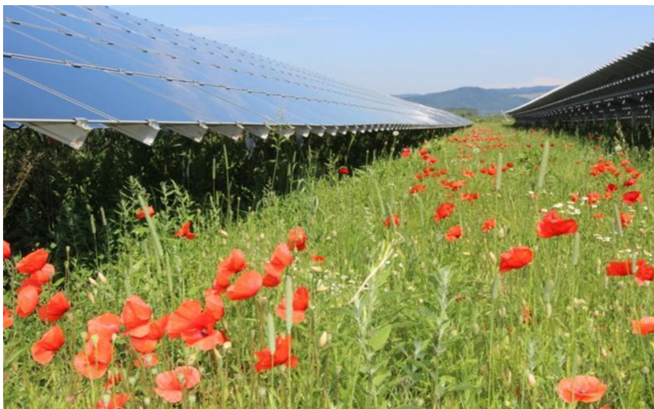
Fot. 10. Przykłady zróżnicowanej szaty roślinnej porastającej tereny farm fotowoltaicznych (źródło: „Solar power plants in the nature”, Belectric Solarkraftwerke GmbH).
