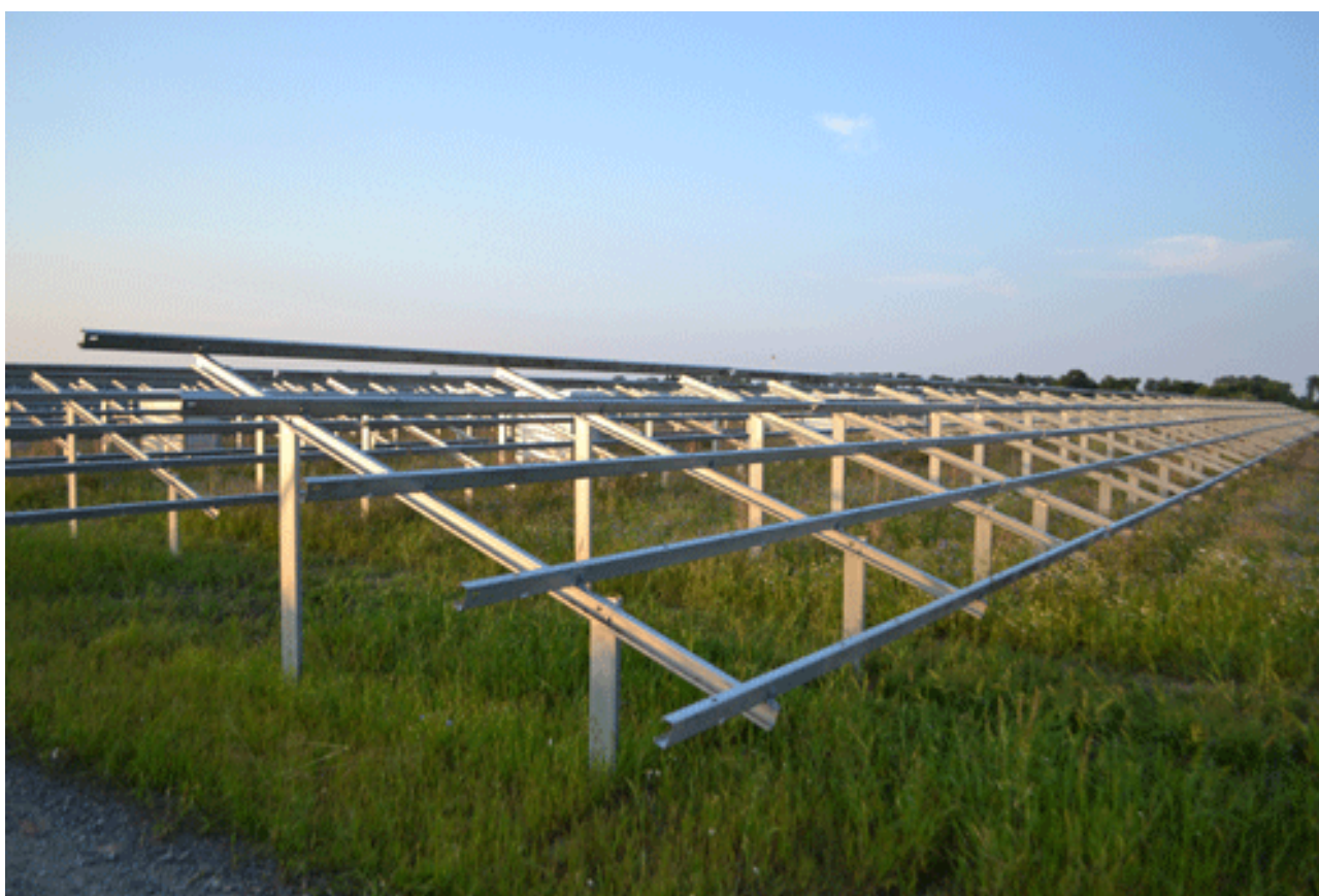
Fot. 2. Stalowa konstrukcja gotowa do montażu paneli fotowoltaicznych (źródło: www.projekt-solarteknik.pl ).
