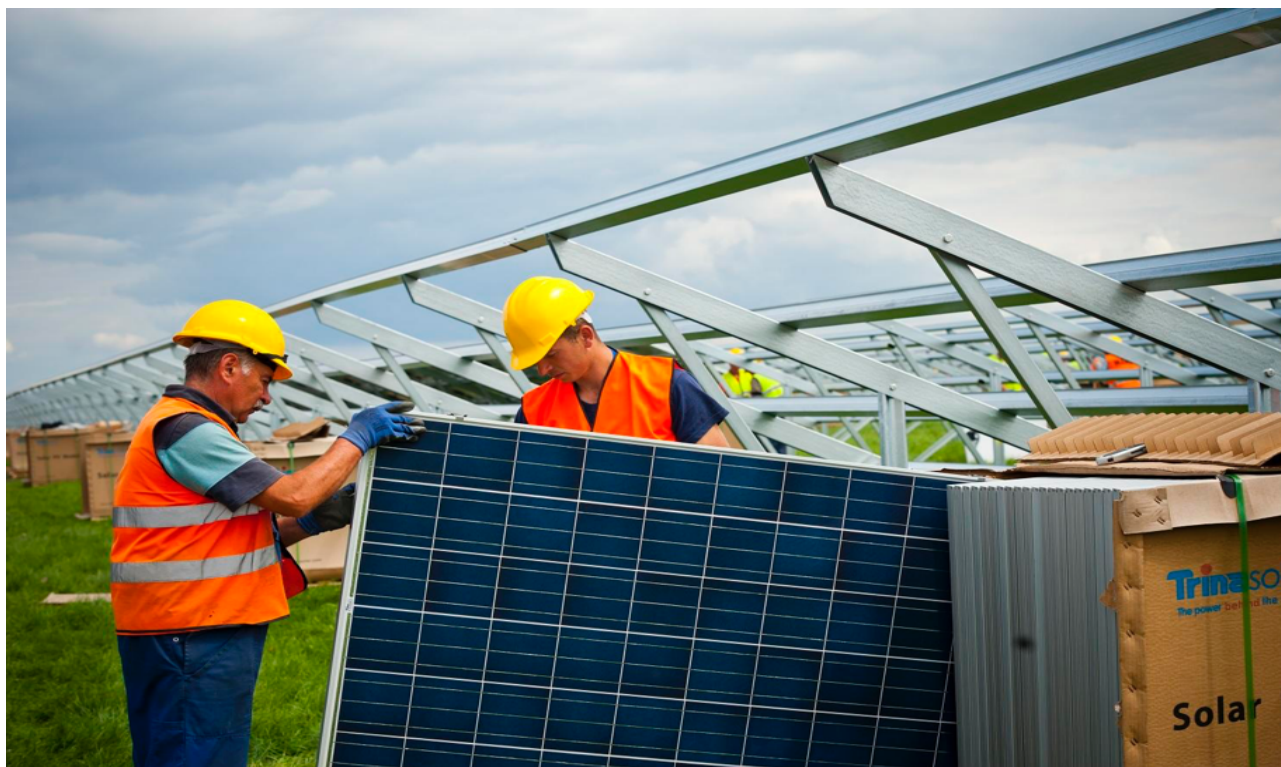
Fot. 3. Montaż konstrukcji stalowych i paneli fotowoltaicznych (źródło: Remor Solar).
